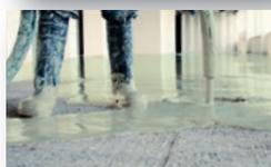
Se incrementa la velocidad de aplicación hasta en un 100% frente a los morteros en sacos al eliminarse la necesidad de mezclar in situ.
